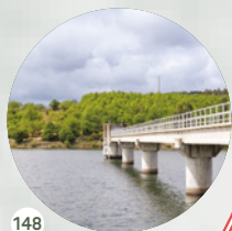
148 Presa de Sambade Sambade
