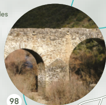
98 Puente de Gestosa Gestosa Puente medieval de la Gestosa que cruza el río Rabaçal, realizando la antigua conexión con el pueblo de Santalha a través de la Calçada, que también tendría conexiones con el pueblo de Cigadonha.
