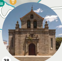
Igreja de Santa Bárbara Sendim
