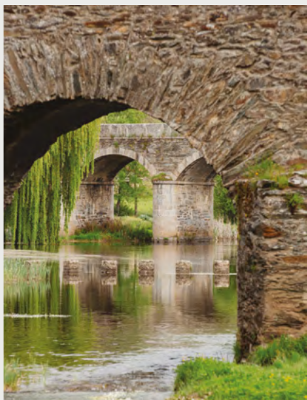
A Ponte de Gimonde ou Ponte Velha, faz a travessia a cerca de oito quilómetros de Bragança, com metros a montante da ponte de finais de século XIX.
