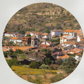
Torre de Dona Chama Mirandela
